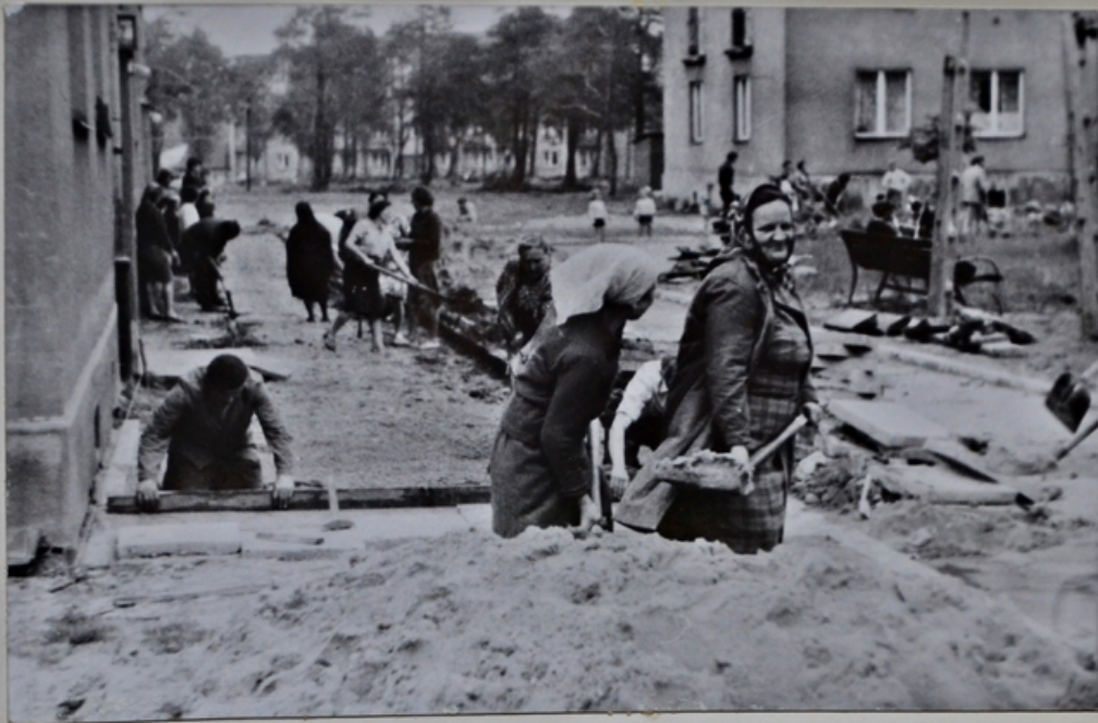
Budowa chodników na osiedlu Ludowego Wojska Polskiego w Bukownie - czyn społeczny pracowników R.Z.B.M.
