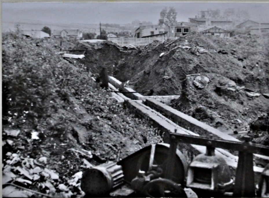
Budowa sieci zdalaczynnej c.o. i c.w.
