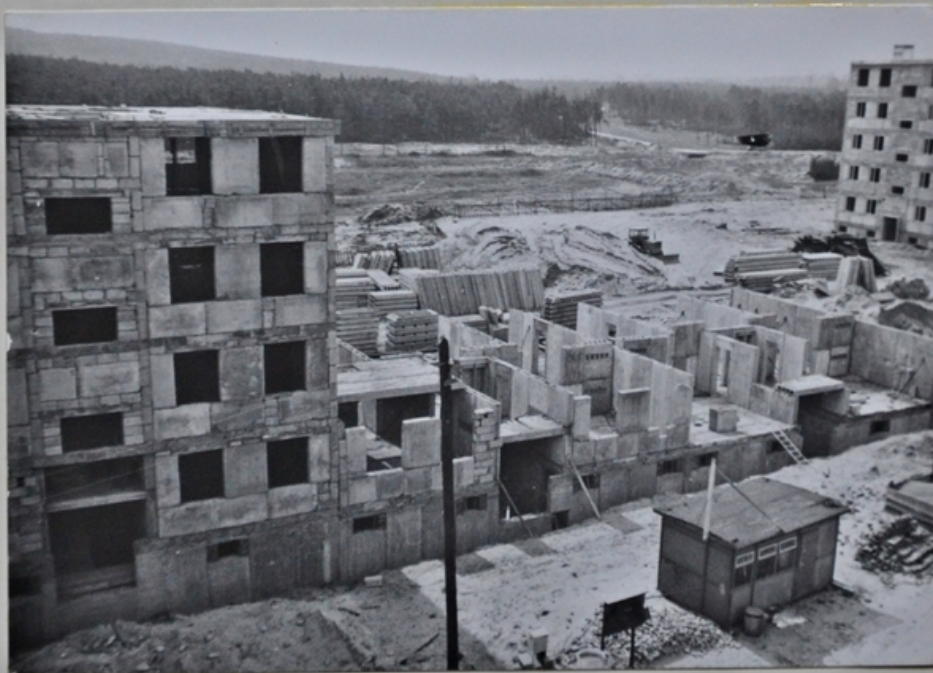
Osiedle 1000-lecia w budowie
