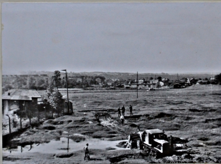
Niwelacja terenu pod budowę bazy przedsiębiorstwa
