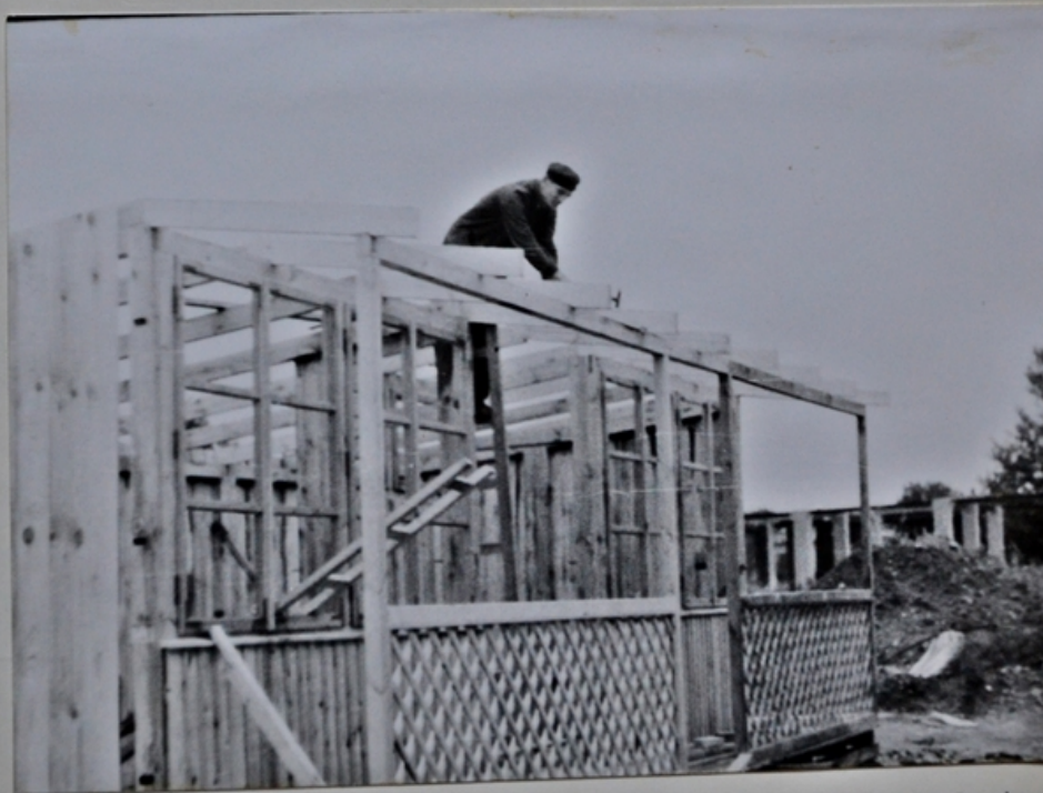
Czyn społeczny pracowników - budowa domku campingowego w Korbielowie
