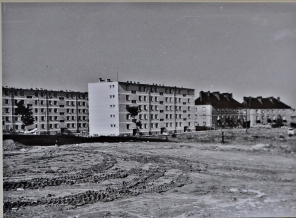
Widok budynków przy ul. Zawadzkiego po wykonaniu elewacji
