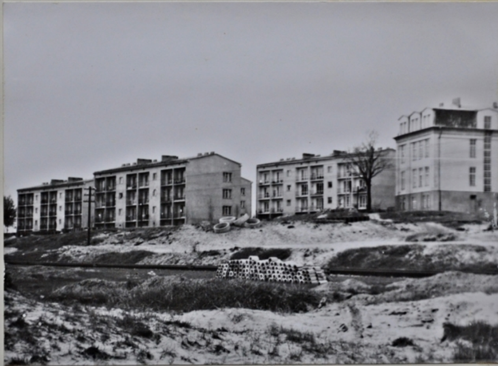
Widok osiedla 22 Lipca od strony torów kolejowych
