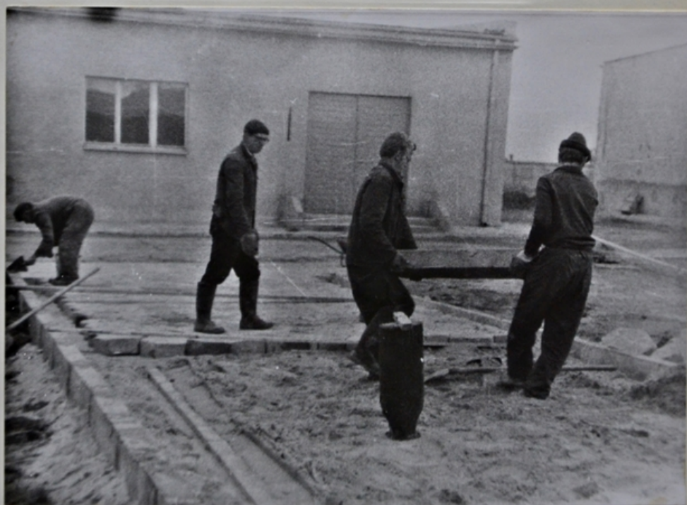
Budowa dróg wewnątrzzakładowych
