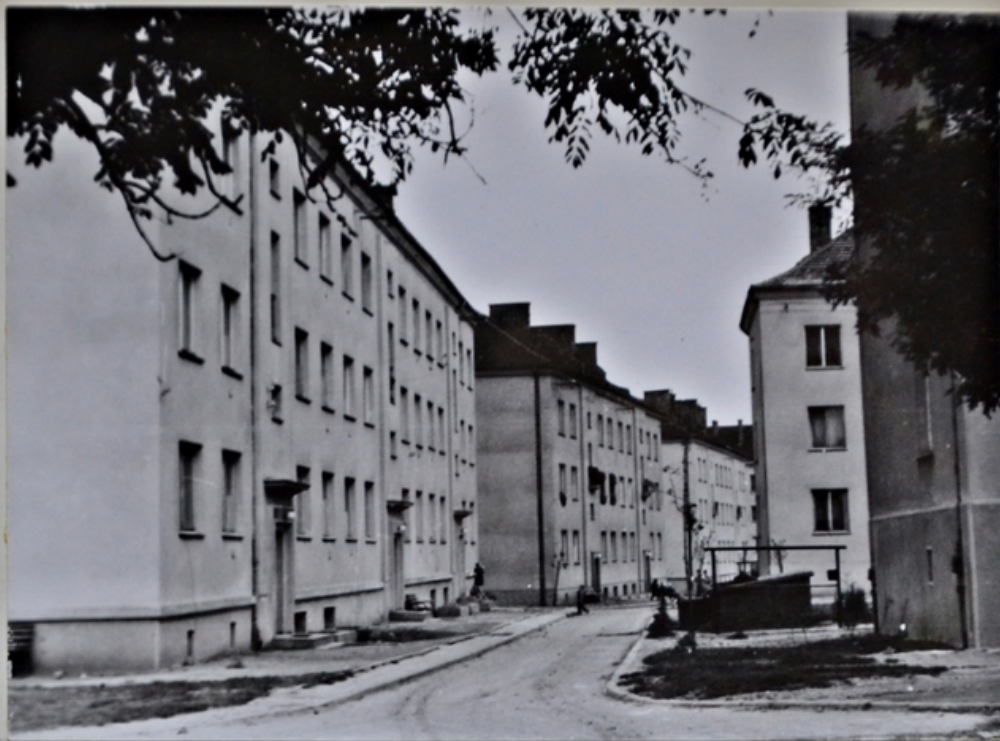
Osiedle Żwirki i Wigury po wykonaniu elewacji budynków
