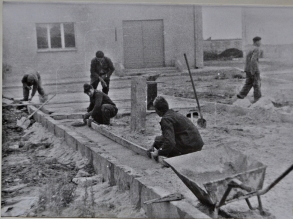
Budowa dróg wewnątrzzakładowych przez Zakład Remontowy
