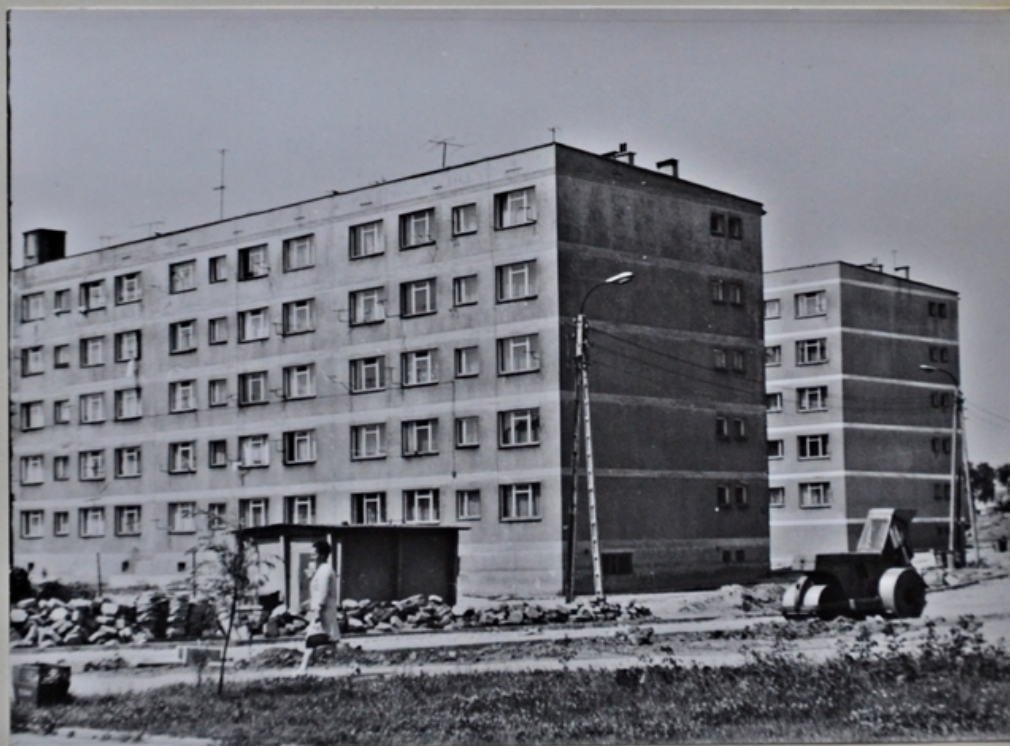
Budowa drogi dojazdowej do budynków przy ul. Zawadzkiego
